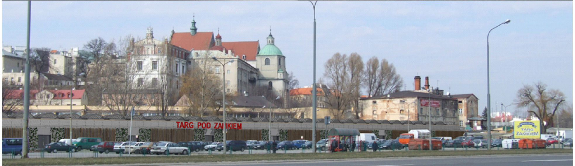
Widok projektowanego zadaszzenia od strony Al. Unii Lubelskiej w kierunku Starego Miasta
