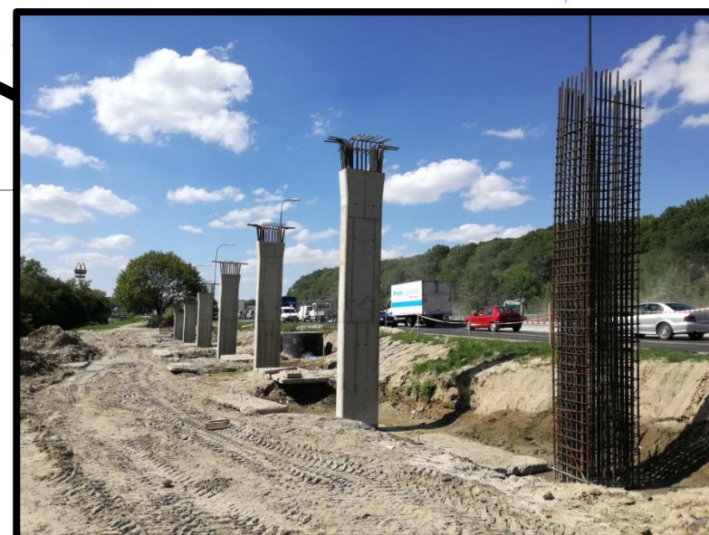
Fot.3. Filary kładki dla pieszych
