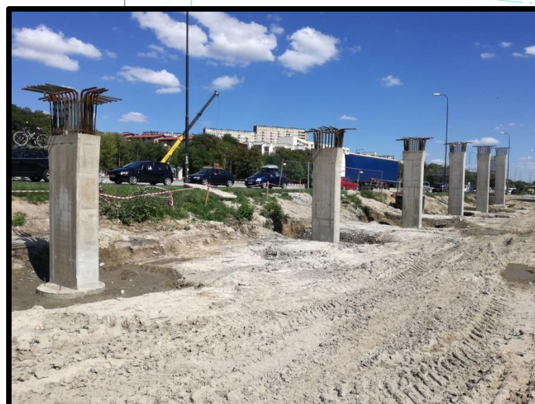
Fot.4. Filary kładki dla pieszych
