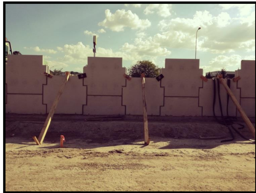
Fot.1. Panele muru oporowego na dojeździe do wiaduktu
