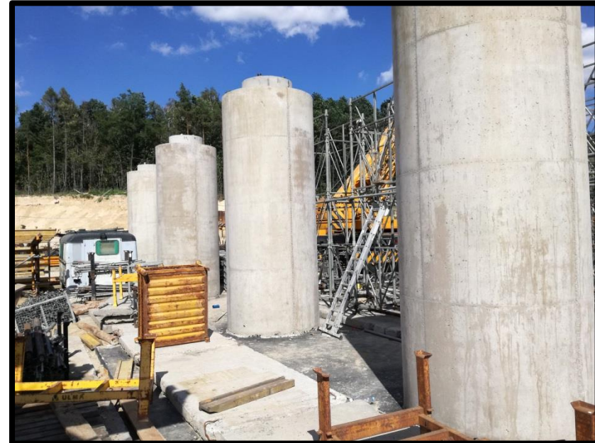
Fot.2. Filary pośrednie wiaduktu
