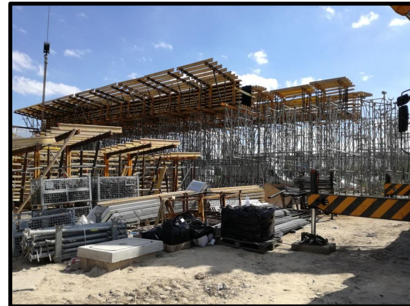
Fot.3. Deskowanie ustroju nośnego wiaduktu
