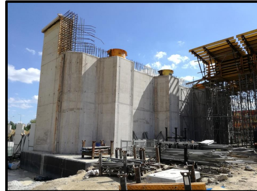
Fot.4. Przyciótek wiaduktu – strona wschodnia
