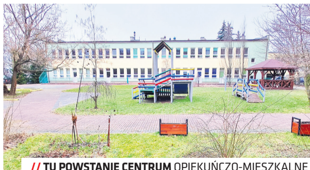
// TU POWSTANIE CENTRUM OPIEKUŃCZO-MIESZKALNE
