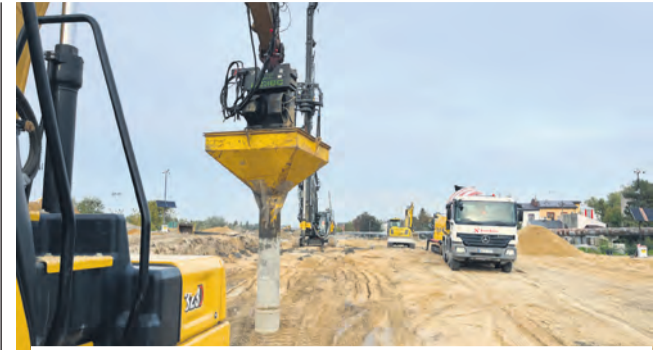
// PRACE PRZY PRZEDŁUŻENIU UL. LUBELSKIEGO LIPCA '80
